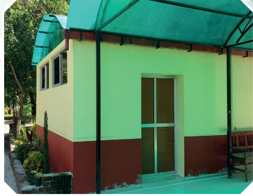
जडिबुटि भण्डारण गृह निर्माण
