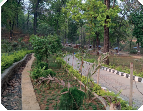
पदमार्ग निर्माण कार्य गौतम बुद्ध राष्ट्रिय उद्यान निर्माण देवदह न.पा.-६
